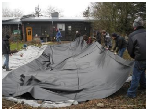
Das Team verlegt die neue Teichfolie Foto: M. Ludwig
