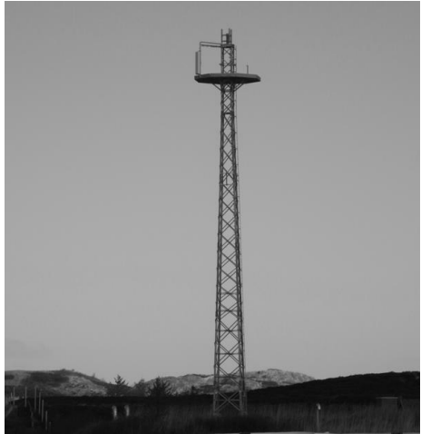
Der letzte BOS-Mast in Schleswig-Holstein, mittlerweile fertiggestellt, Standort Industrietal List. Foto: M. Ludwig
