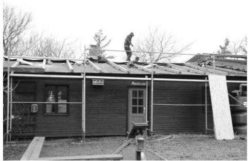
Die Dachsanierungsarbeiten am Naturzentrum Braderup. Foto: P. Grösch
