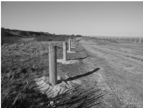
Neue Pfosten und Riegel zur Besucherlenkung auf dem Weg in Richtung Pük Deel. Foto: M. Ludwig
